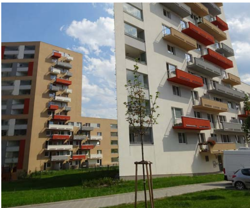
Bytový dům Hornoměcholupská zateplovací systém weber therm klasik, povrchová úprava weber.pas extraClean a weber.pas silikon
